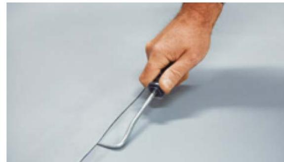
FIG. 22. Control de Soldadura.
