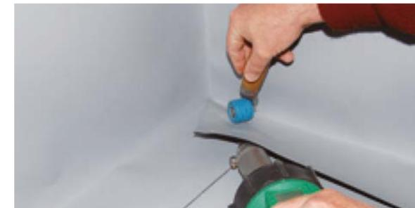
7. Pase el probado de junta por las diferentes uniones verificando el termosellado, cuando la membrana se encuentre fría.
