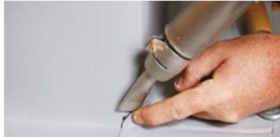
10. Verificar las soldaduras con el probador al terminar y cuando la membrana ya se encuentre fría.
