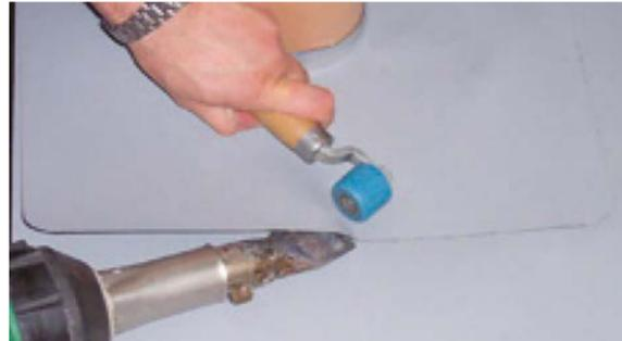
6. En la parte vertical solde otro tramo de membrana tapando el elemento. Con aire caliente deforme el borde para poder soldarlo.
