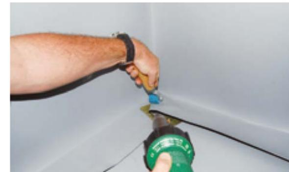
6. Luego termofunda el pliegue ya adherido a la capa inferior, presionando muy bien con el rodillo todas las capas que allí estan.
