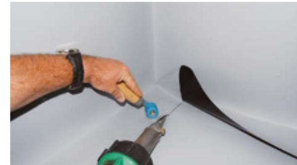
5. Con ayuda de algun elemento metálico separe el triángulo generado y termofundalo.
