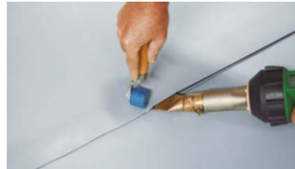
FIG. 21. Soldadura Final Borde.
