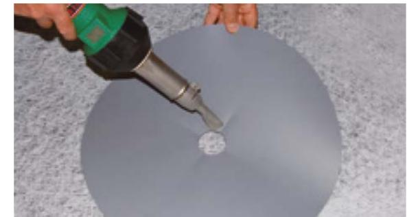
4. Con el material caliente abra el orificio para poder introducir el elemento que pasa por allí.
