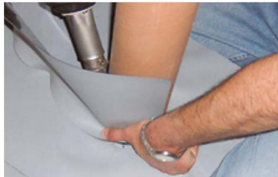
7. Termine el proceso de soldadura y verifique la misma con el probador.
