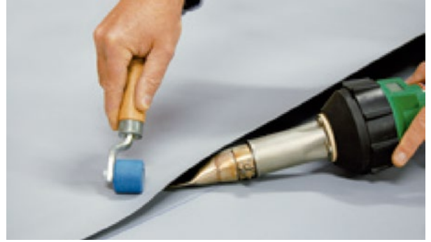
FIG.20. Pre-soldadura.
