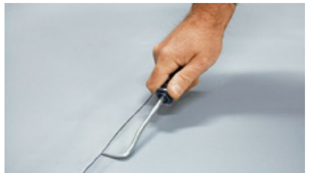
FIG. 22. Control de Soldadura.
