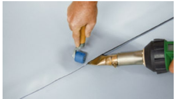
FIG. 21. Soldadura Final Borde.
