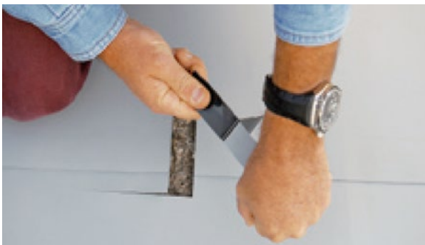
FIG.17. Prueba de Desprendimiento TPO
