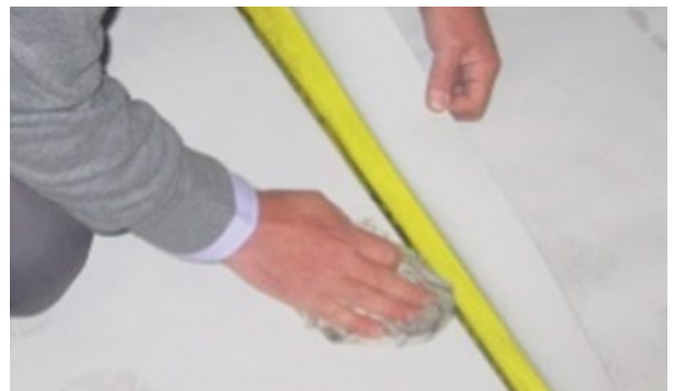
FIG. 18. Limpieza de Solapas.
